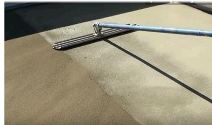
Introducir el mortero en la superficie mediante el uso de la llana
